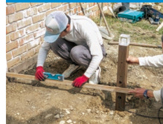
専門スタッフが施工
